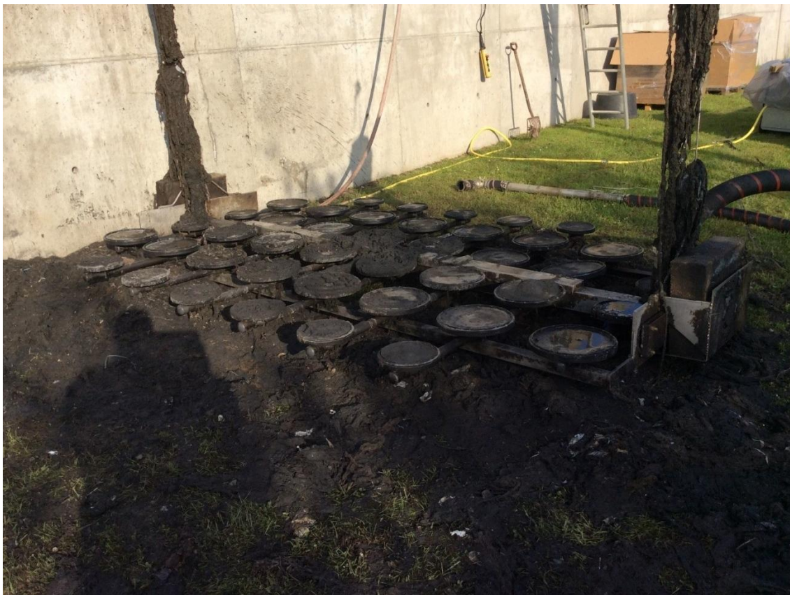
En sektion med tallerken-diffusere er løftet ud af procestanken på Skive Renseanlæg for udskiftning. Der er udskiftet i alt 2.500 tallerkner.
