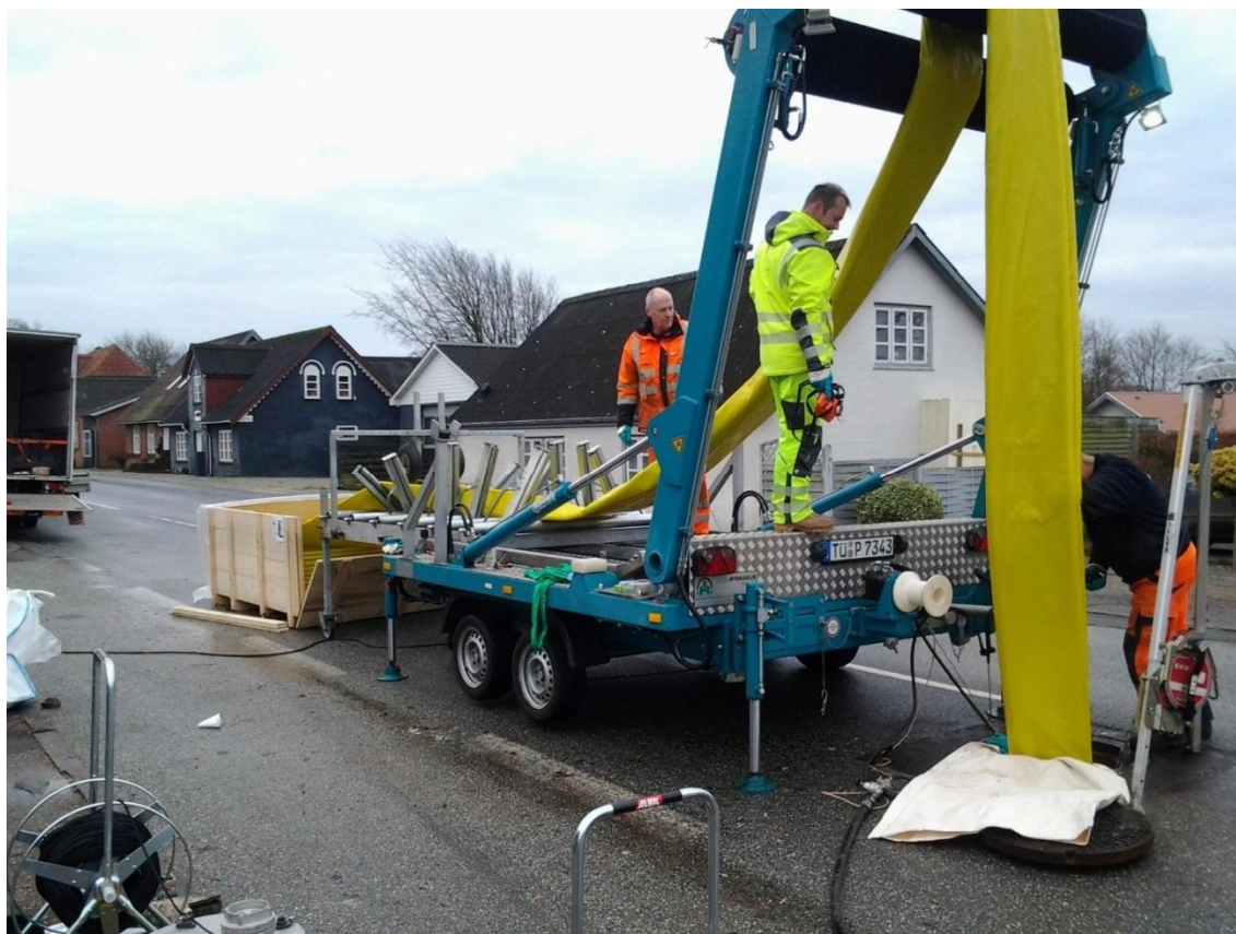
Glasfiberstrømpe trækkes ned i hovedkloak på Nørregade i Balling. Når strømpen er på plads, fyldes den med varmt vand, hvorefter strømpen hælder op og bliver et nyt kloakrør inden i det gamle kloakrør.
