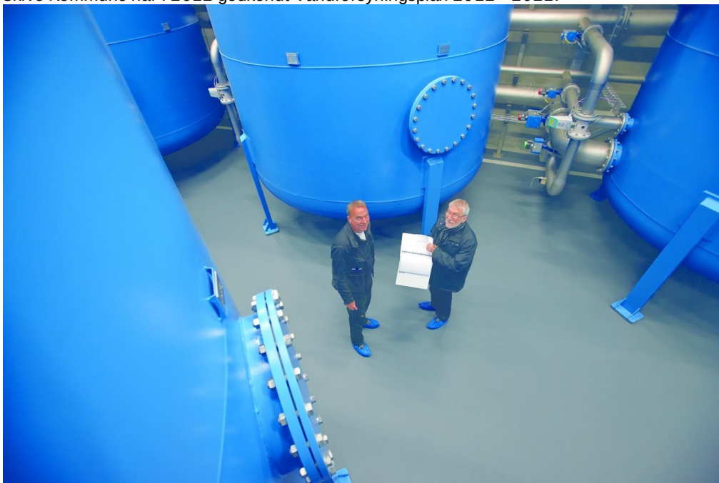
Filterbeholdere på Skive Vandværk.
