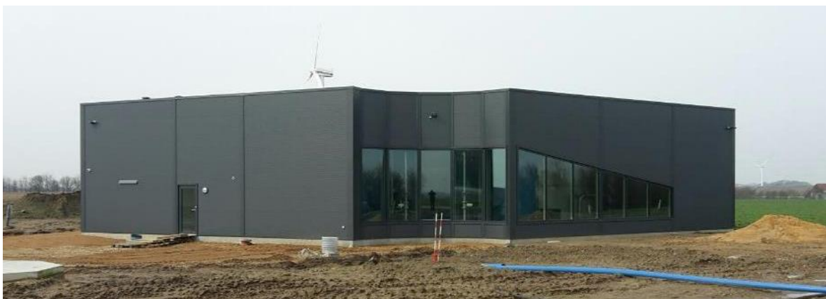
Det nye Vihøj vandværk er klar til indkøring og idriftsættelse.
