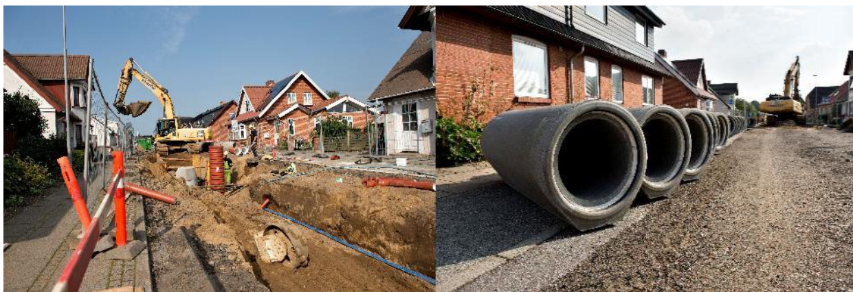
Separatkloakering i Lem. De tynde røde rør på venstre billede er til spildevand og de store grå betonrør på højre billede er til regnvand.
