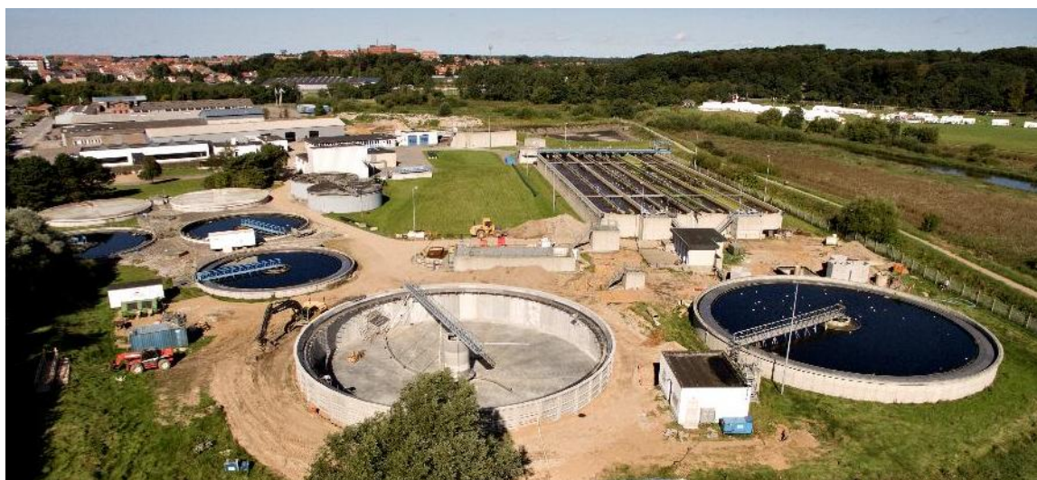
Den nye efterklaringstank ses i forgrunden på billedet. De 3 åbne og de 2 lukkede tanke til venstre i billedet bliver fjernet.
