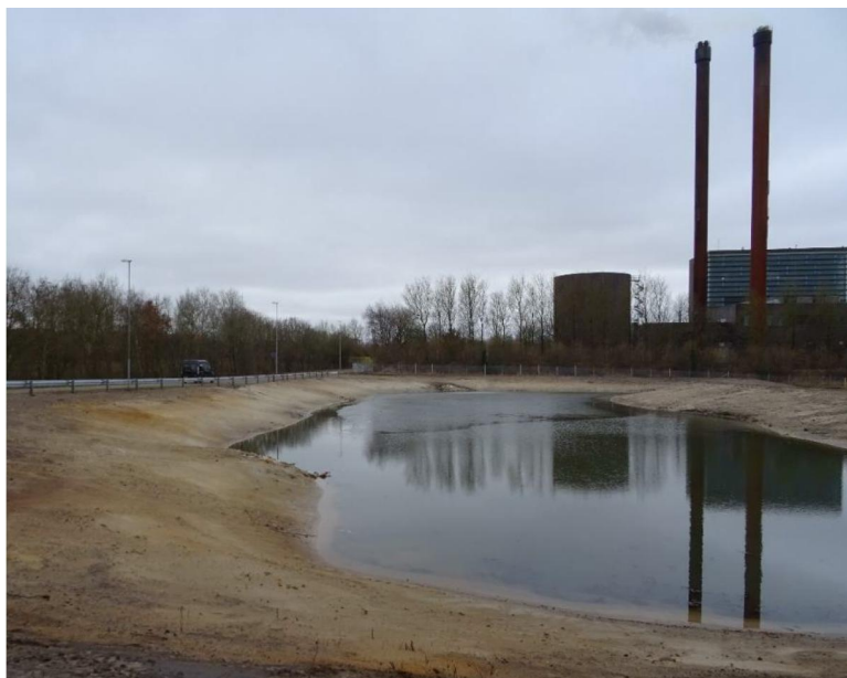
Nyt regnvandsbassin ved Thorsvej i Skive.
